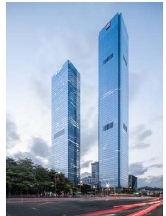
深业上城位于深圳福田北赛格日立工业园旧址，作为项目规划、设计及总协调方，华阳国际与众多世界顶尖设计团队共同承担南区两座超高层塔楼、三栋高层产业研发用房、一栋高层酒店宴会厅及商业的设计，探索复合型城市综合体的新表达方式。高378米（T1）和292米（T2）超高层、大跨度产业研发大厦构成地标双塔。8个巨柱、核心筒、框架梁和周边带状桁架共同组成了高塔新型抗侧力体系，形成了规则、高效、灵活的办公空间。3米宽的玻璃幕墙迎向莲花山和笔架山，形成丰富、舒适的办公视野。
