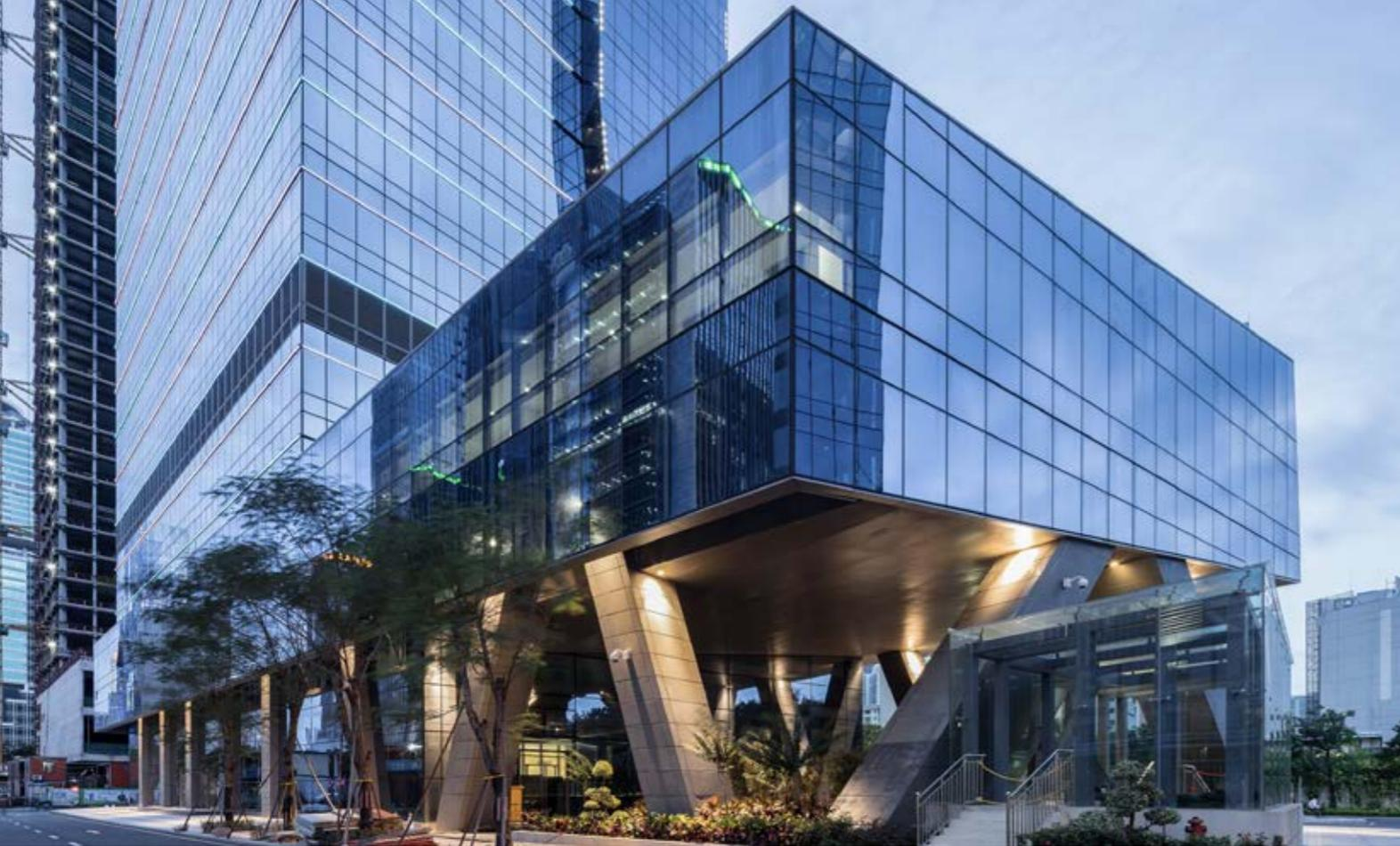
中国人寿处福田 CBD，如何营造一个既能反映传统企业文化，又具有活力的有机体成为设计师关注的重点。设计从企业 LOGO 及“人寿”二字中汲取灵感，将底层结构抽象为具有强烈美感的“树根状斜柱”。同时，项目被分为南北两个体量，南边体量一方面附着一个三维 U 型裙房，裙房与塔楼交接处形成折面，微微向城市主展示面延伸，另一方面环抱北面体量，在不断上升中汇聚转化为一个完整建筑。
