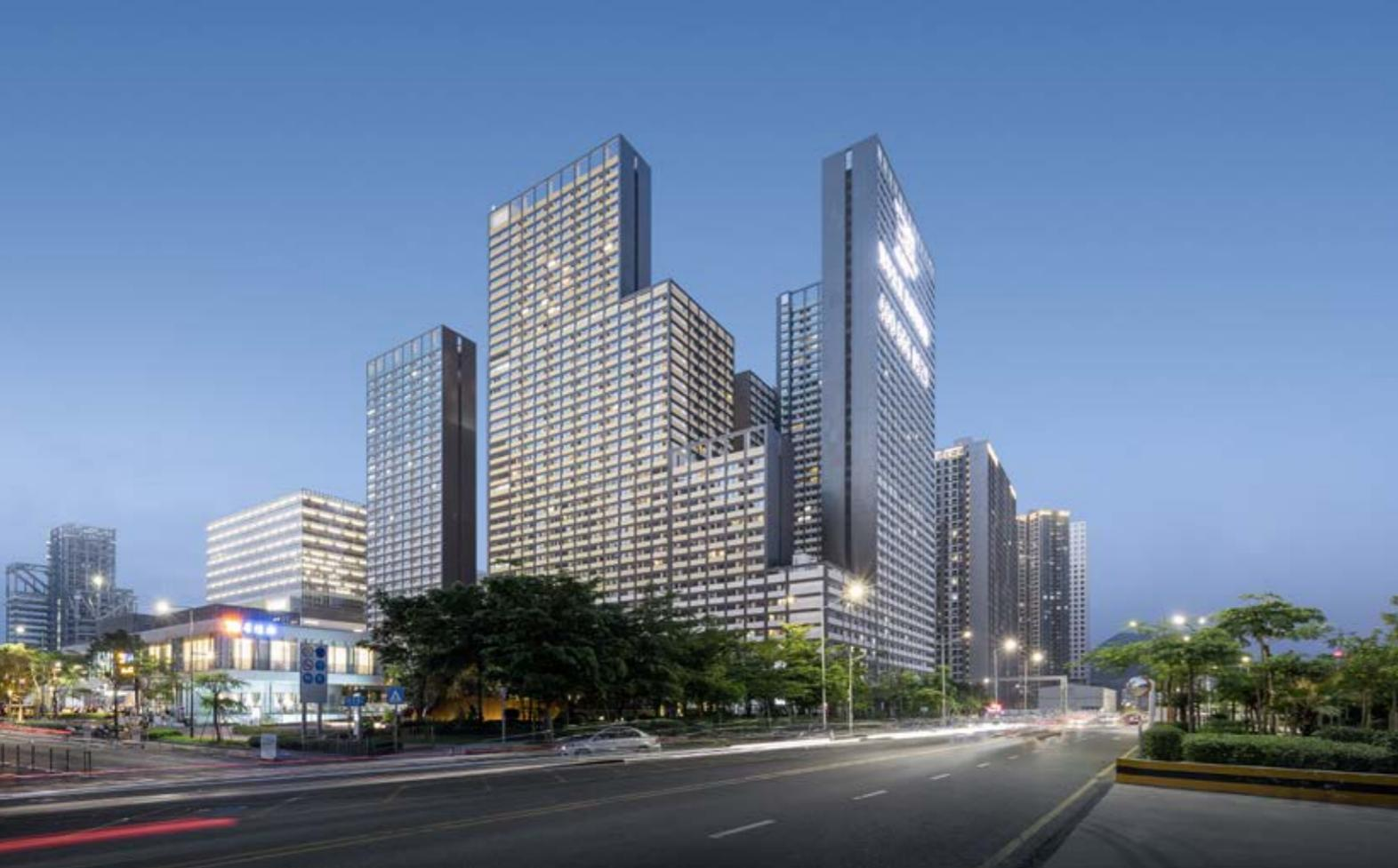
万科云城位于深圳南山留仙洞总部基地，处于深圳科技创新发展轴重要节点，是南山产学研基地的重要一环。从城的建造，到复合产业的场景营造，项目致力于在超40万平方米城市边缘秃地，突破传统产业园模式，以高度复合空间格局叠加多元产业生态系统，创新对话体验，激活城市氛围。同时，在建造方式的选择上，采用100%装配式构件拼装而成，首创全国大规模建设的装配式高层办公建筑群典范。
