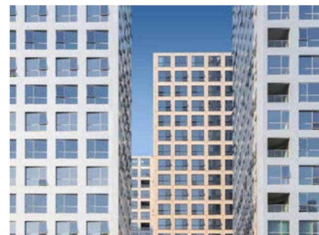
在办公界面塑造上，项目打破以玻璃幕墙为主导的办公建筑时代，探索装配式混凝土技术在办公建筑中的应用与实践。万科云城一期，近 10 万平方米标准层建筑外立面，以“少规格、多组合”的设计方式，100% 全采用“装配式构件”拼装而成，在标准构件立面单元的不变中，寻求“窗”元素的表达变化，利用“深窗”、“平窗”、“斜窗”等手法，打造出城市界面独特的律感，成为全国首个大规模建设的装配式高层办公建筑群。
