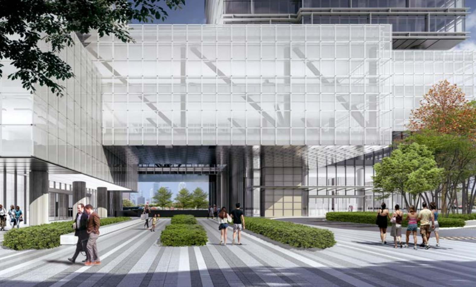
深圳清华大学研究院新大楼位于南山高密布局片区，周边围绕大量办公楼。为突破高密度、高容积率、用地局促等限制条件，设计采用对角线“双塔”布局，缓解城市密度压力，避让周边建筑，形成良好的视线通廊和城市空间格局。通过体块堆叠、底层架空，以及刻意压低 6 米的首层空间，让建筑形态呈现“进阶”的概念，并创造出有遮盖、有阴凉、尺度宜人的活动场所。
